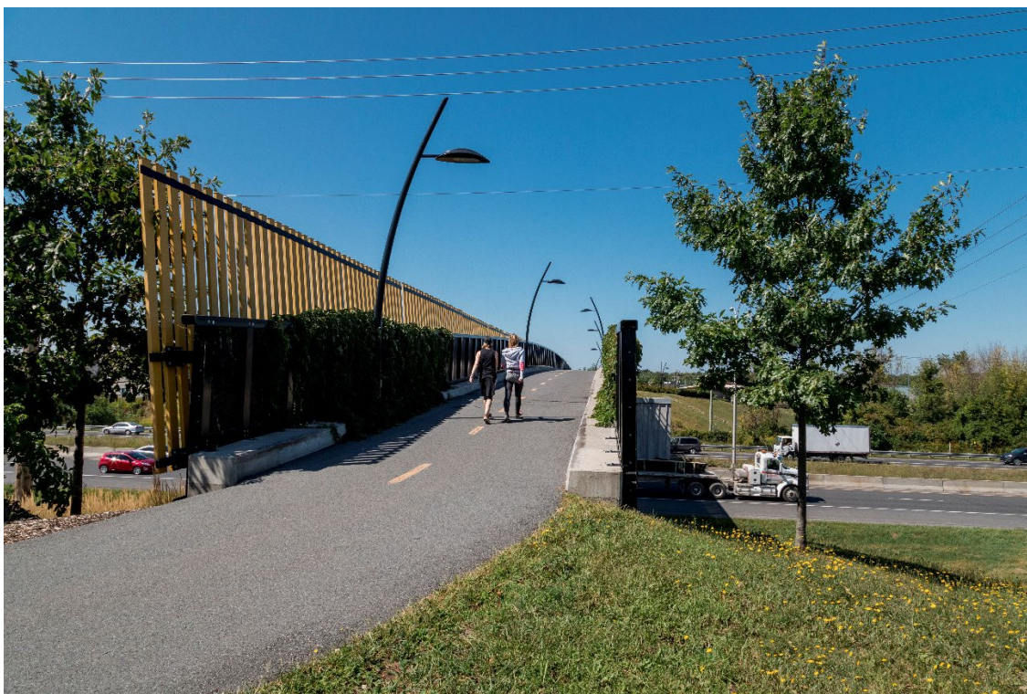
Figure 6 : Passerelle pour piétons et cyclistes au-dessus de l'autoroute 15, Candiac
