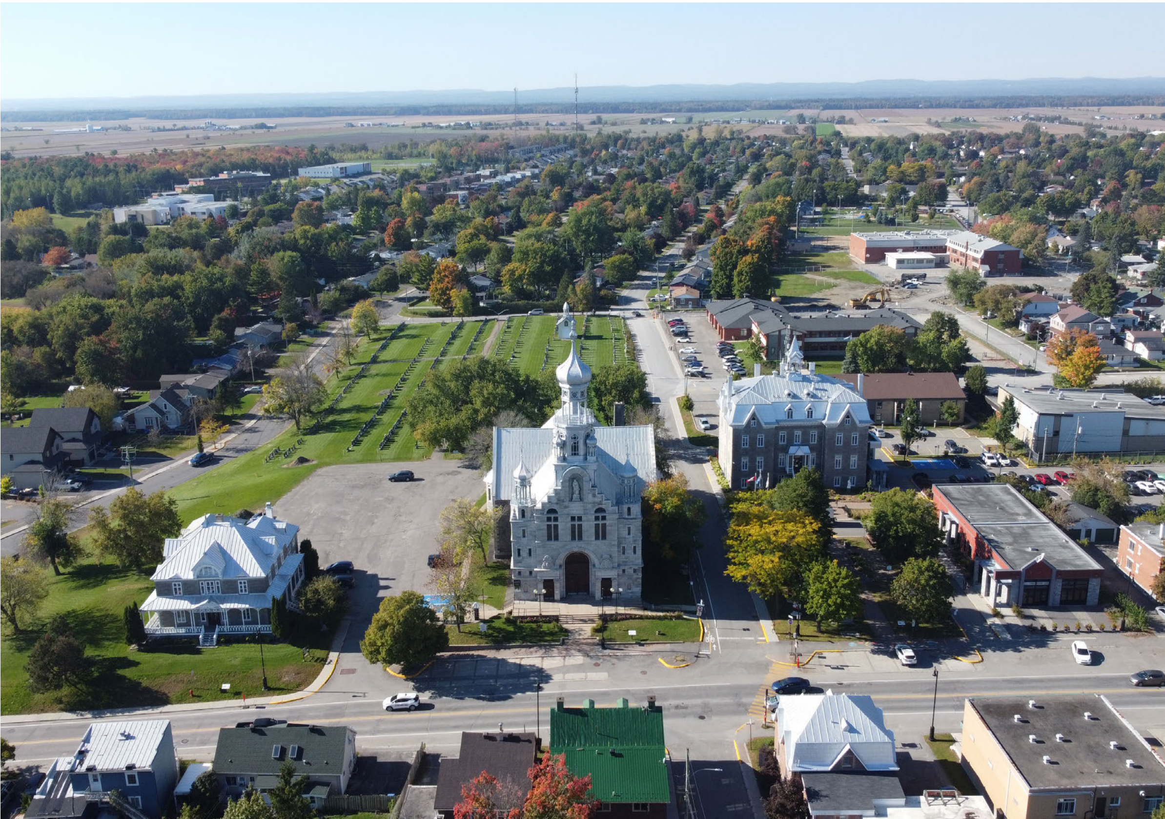
Vue aérienne de l'ensemble institutionnel.
