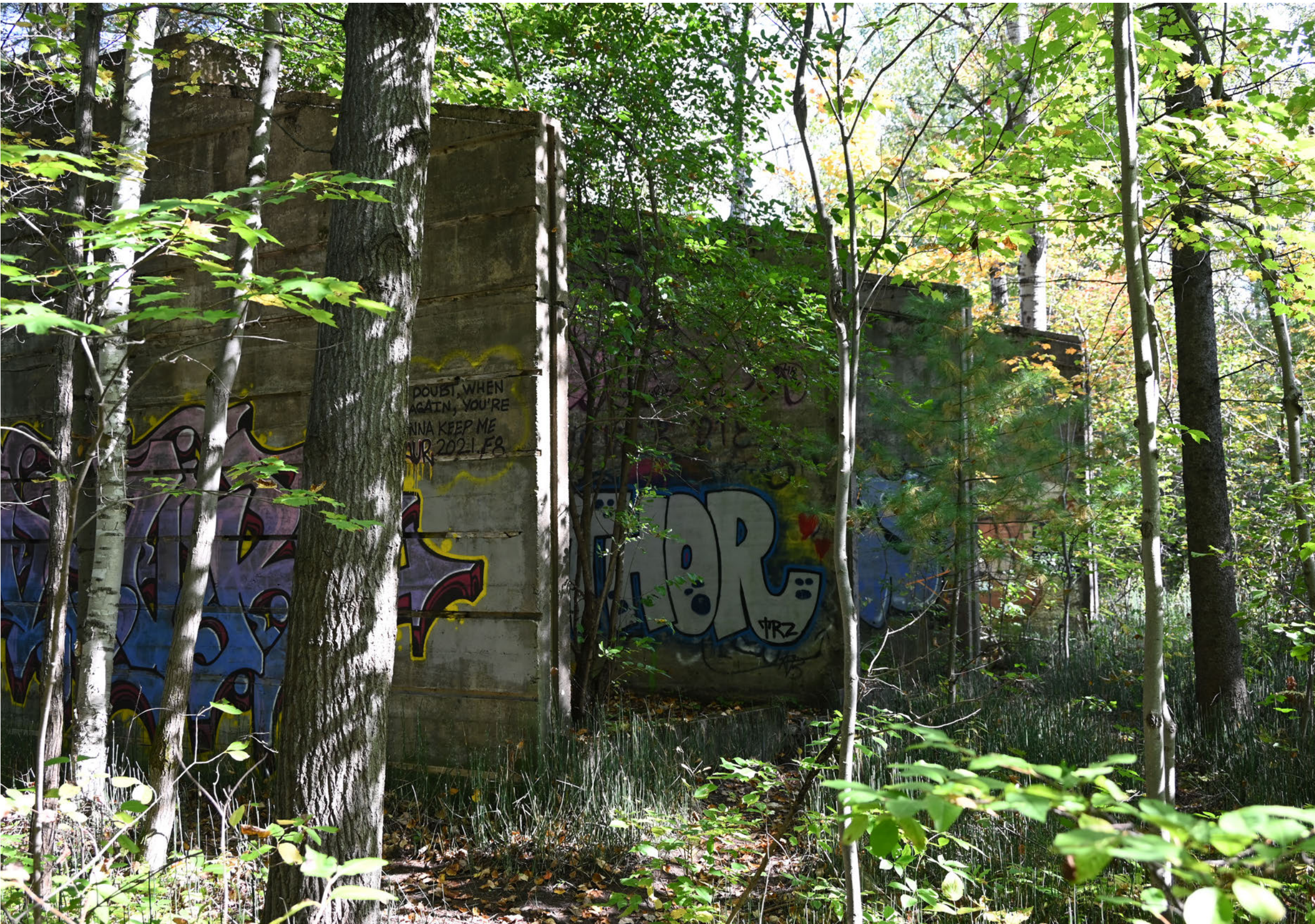
Regroupement de structures en béton armé.
