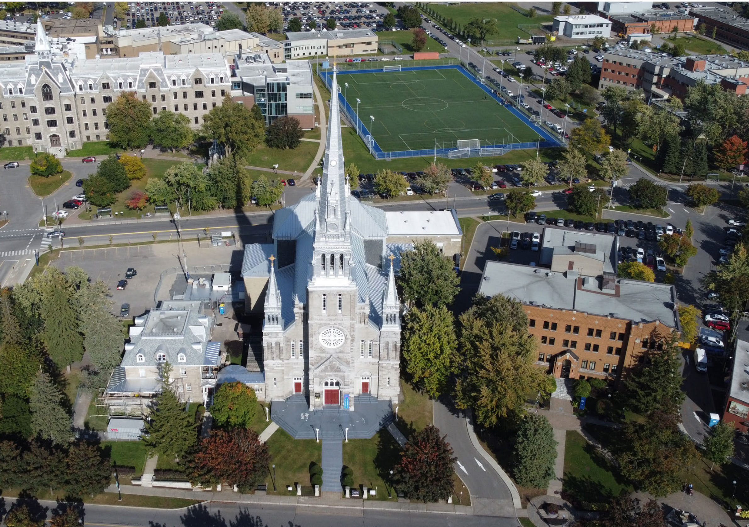
Vue aérienne de l'ensemble institutionnel.
