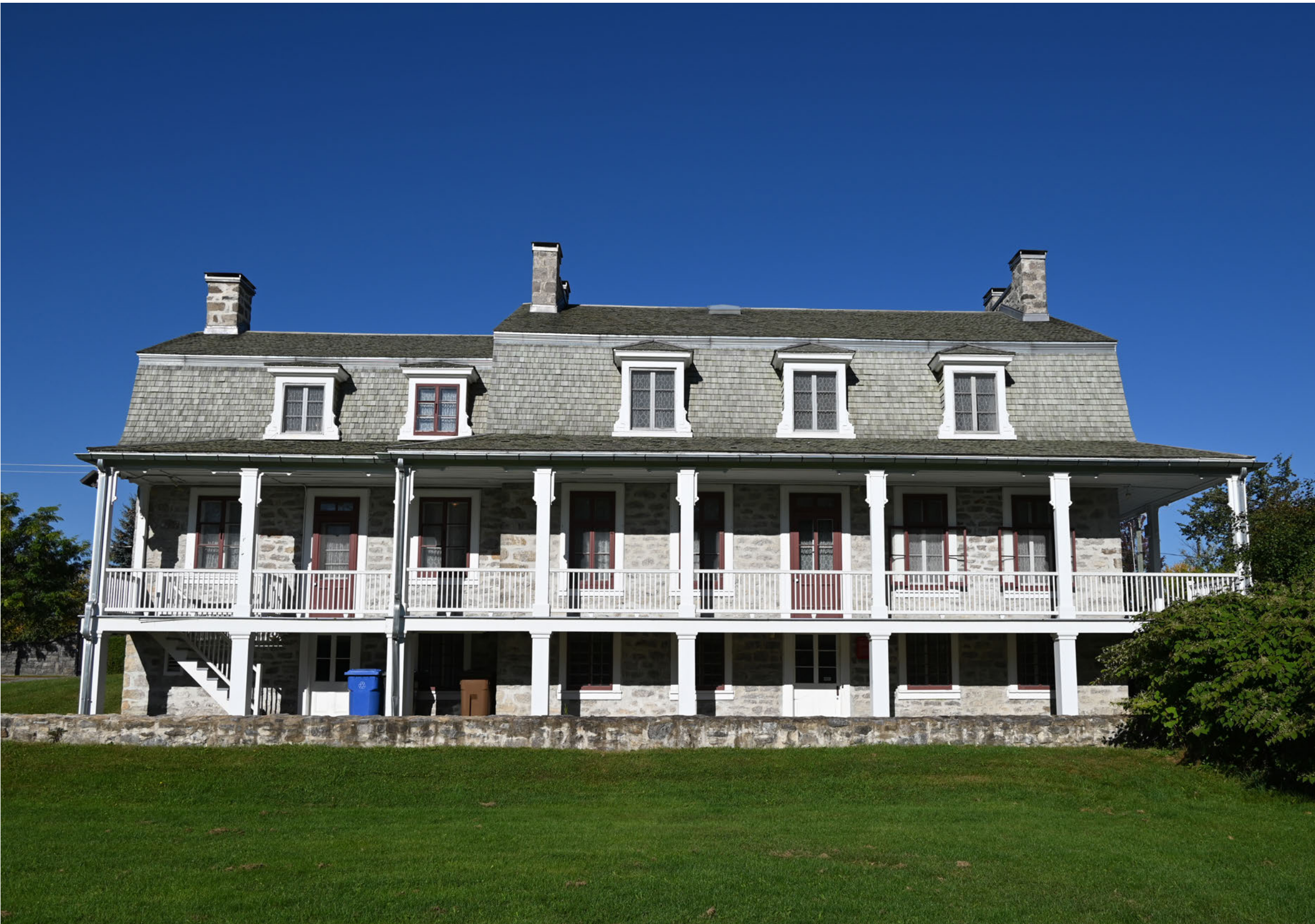
Façade arrière de la maison Garth montrant le corps initial et l'annexe.
