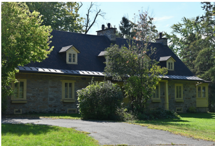
Fig.21 Façade principale de la Maison Val-Marie.
