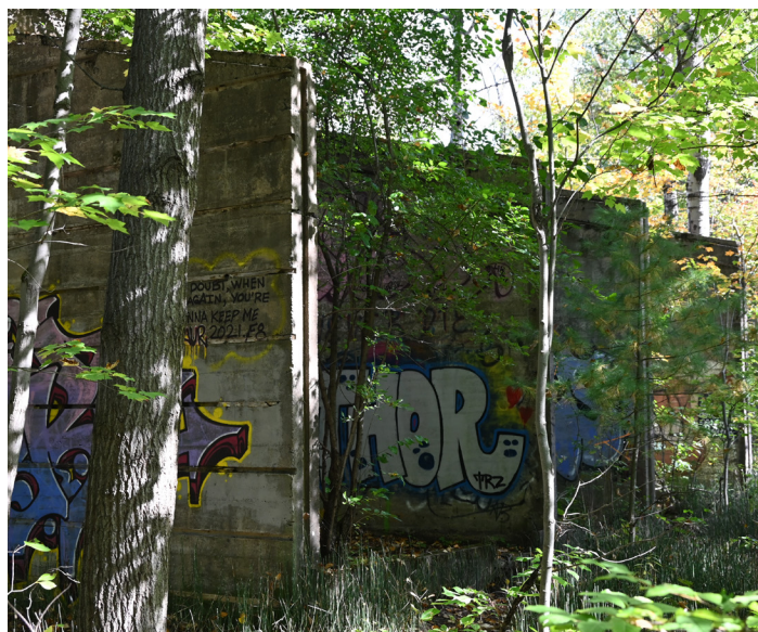
Fig.22 Regroupement de structures en béton armé.
