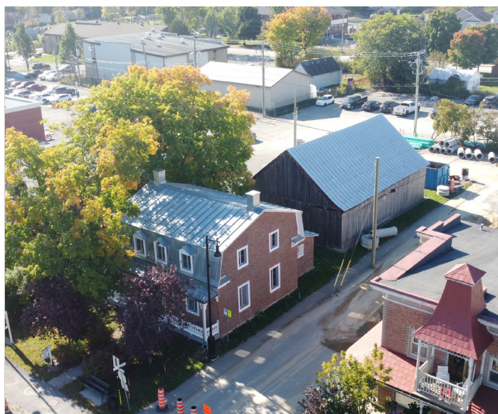
Fig.14 Vue de haut du site de la maison des Prêtres-Chaumont.
