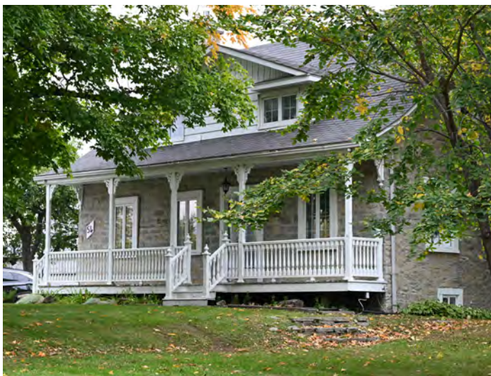
Fig.4 La maison Jean-Charles-Dubois à Boisbriand est un exemple de ce type architectural construit durant la phase vers 1776.
