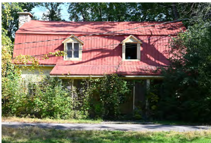
Fig.4 Façade principale de la maison du jardinier, maintenant la maison des Soeurs de l'Archevêché.
