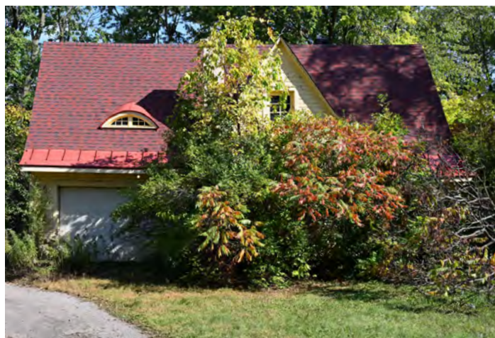
Fig.5 Façade principale de l'écurie, maintenant l'atelier.
