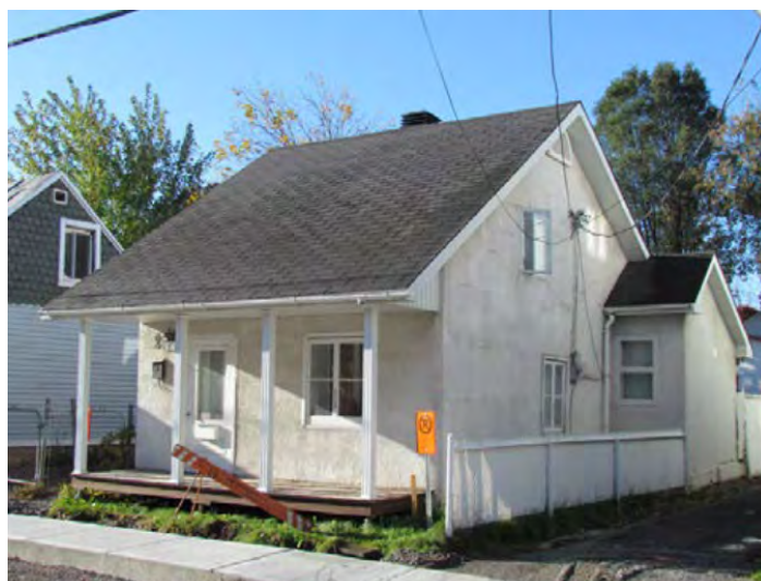
Fig.7 Bergeron Gagnon inc. (2015) Exemple d'une maison coloniale construite entre 1870 et 1900, située au le 24, rue Saint-Lambert, Sainte-Thérèse.
