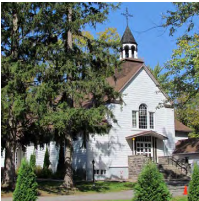
Fig.2 Façade avant de l'église Sainte-Françoise-Cabrini. IMG_0937.jpg
