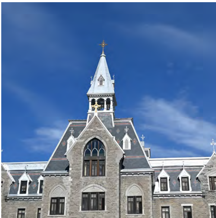
Fig.4 Détails de la toiture de l'ancien Séminaire de Sainte-Thérèse.
