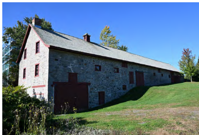
Fig.5 Façade principale de la grange-étable.
