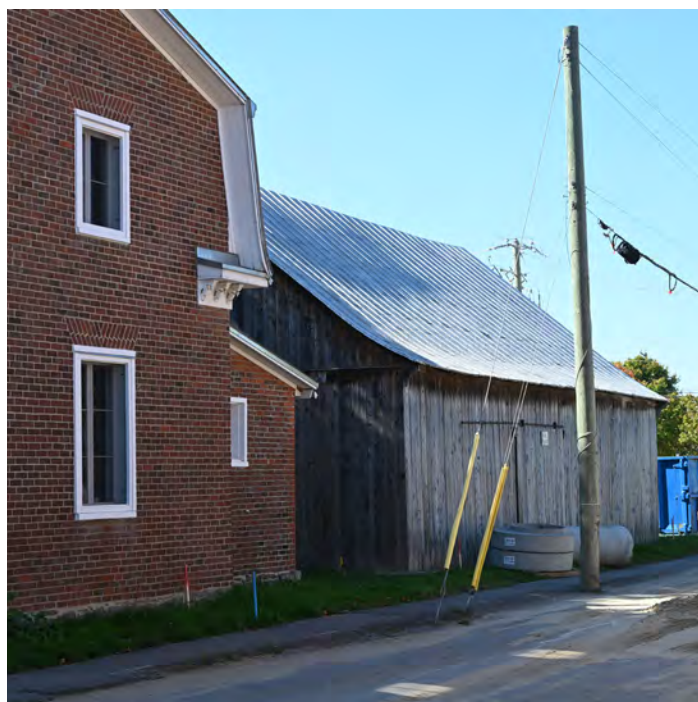
Fig.6 Façade nord-est de la maison et de la grange-écurie.
