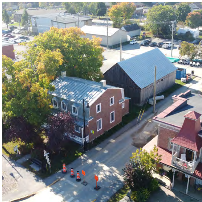
Fig.3 Vue de haut du site de la maison des Prêtres-Chaumont.
