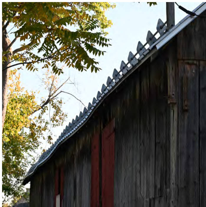
Fig.4 Détail de la grange-étable de la Maison-Hamilton.
