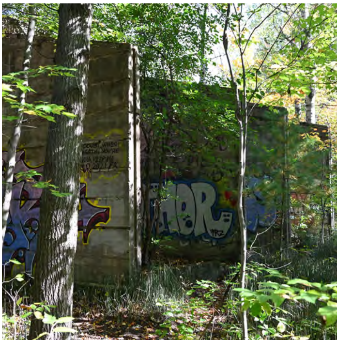
Fig.6 Regroupement de structures en béton armé.
